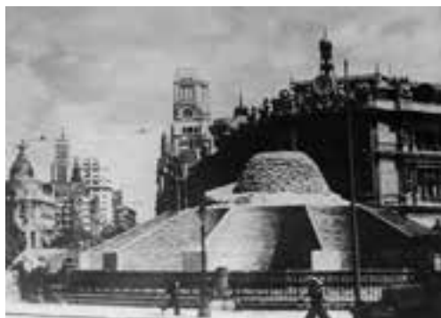
Junta de Protección del Tesoro Artístico Nacional. Protección antibombas para la fuente de la Cibeles, Madrid, 1936 (AFG)
